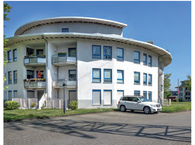
Runde Formen, viele Fenster und Balkone mit hellem Anstrich machen die Wohnanlage sehr einladend. (Fotos: GSE)
