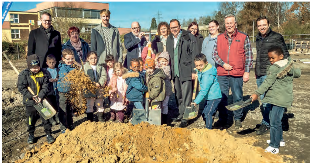
Startschuss für den Neubau: Politiker, Bau-Verantwortliche und KiTa-Kinder waren beim Spatenstich an der Baustelle fleißig vor Ort. (Foto: Allbau)
